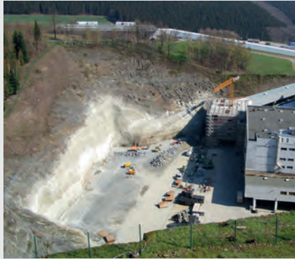
Felsabtrag u. Hangsicherung Veltins | Meschede
