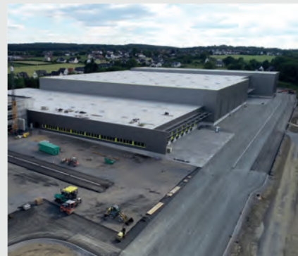
Neubau Hauptsitz TRIO Leuchten | Arnberg
