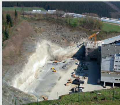
Felsabtrag u. Hangsicherung Veltins | Meschede
