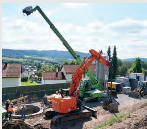
Schachtteufarbeiten | Stockheim (Oberfranken)
