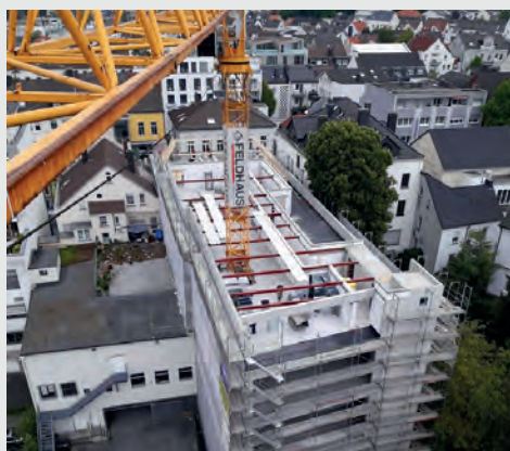
Neubau Modehaus Kress | Arnberg-Neheim
