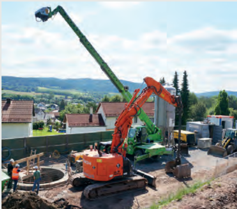
Schachteufarbeiten | Stockheim (Oberfranken)
