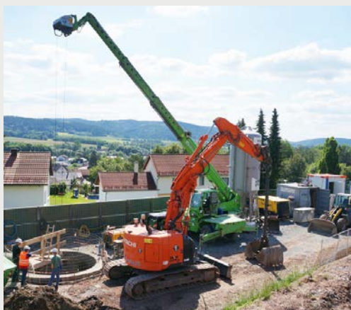
Schachtteufarbeiten | Stockheim (Oberfranken)
